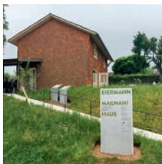
Die Eiermann-Magnani-Dokumentationsstätte in der Adolf-Kolping-Straße. (Foto: Stadt Buchen)
